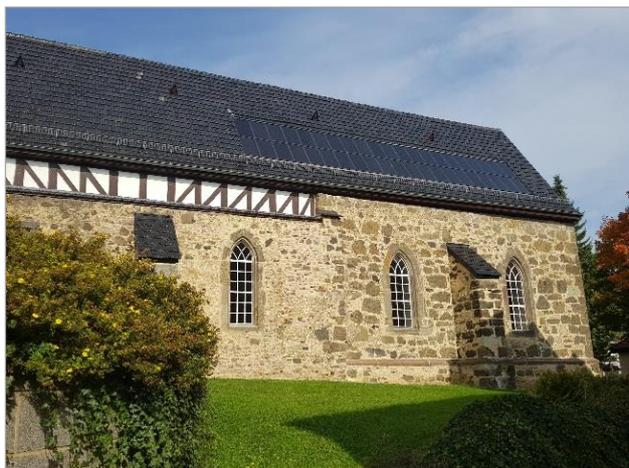
Abbildung 85: optisch integrierte Solarstromanlage
